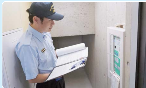
消防設備設置検査
