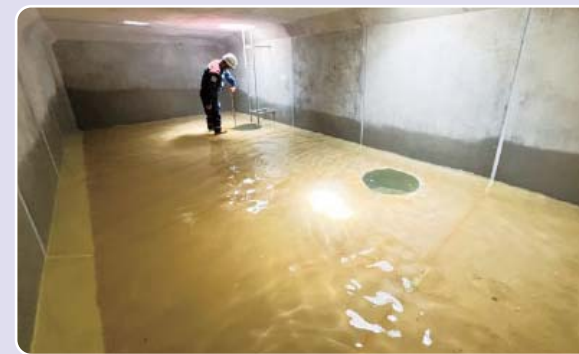
防火水槽の中間検査
