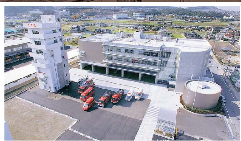
【平成16年】本部・南部消防署新庁舎
