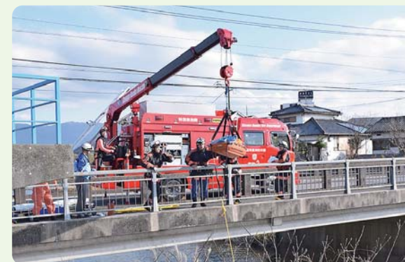
低所からの吊り上げ
